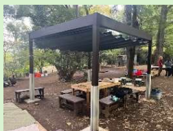
プレーパーク内に日除けを整備した事例
