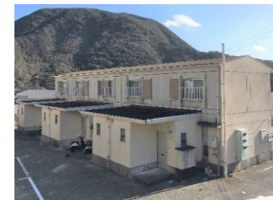
改修予定の公営住宅
